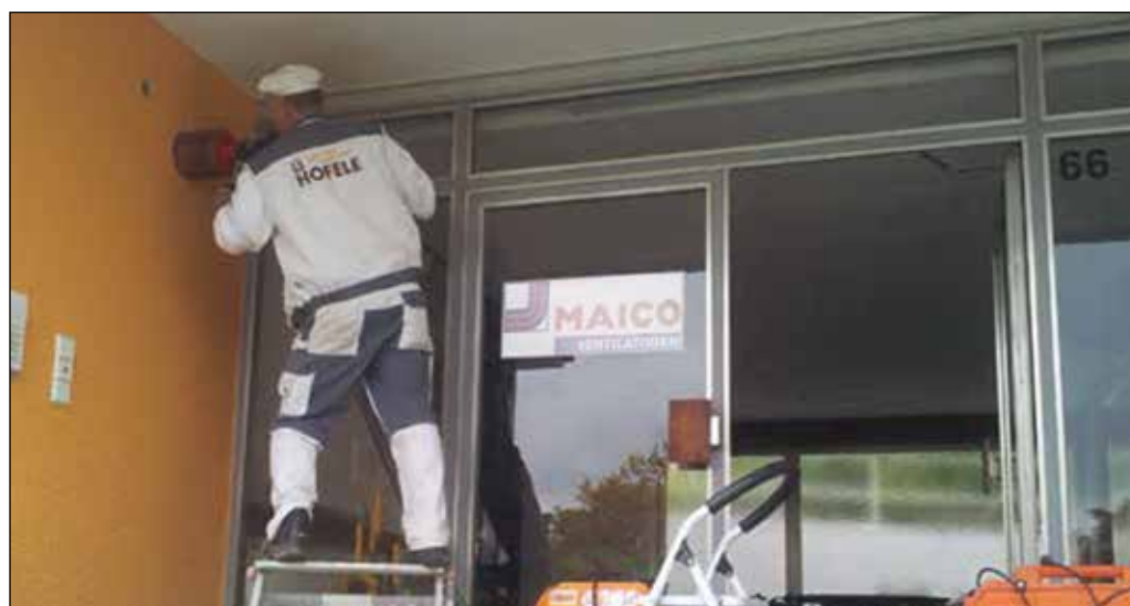
Jürgen Hofele bohrt ein Loch in die Außenwand für das Lüftungssystem.
