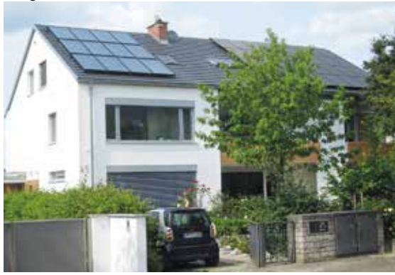
Saniertes Haus in Stuttgart: Vor dem Einbau einer neuen Heizung sollte man das gesamte Gebäude betrachten und zunächst an eine sinnvolle Dämmung denken. Foto: Zunkunft Altbau Bauer
