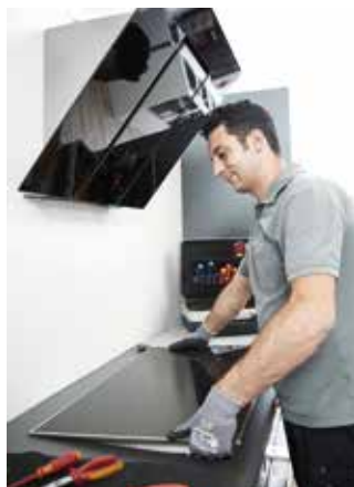
... Geräte werden eingebaut, ...
