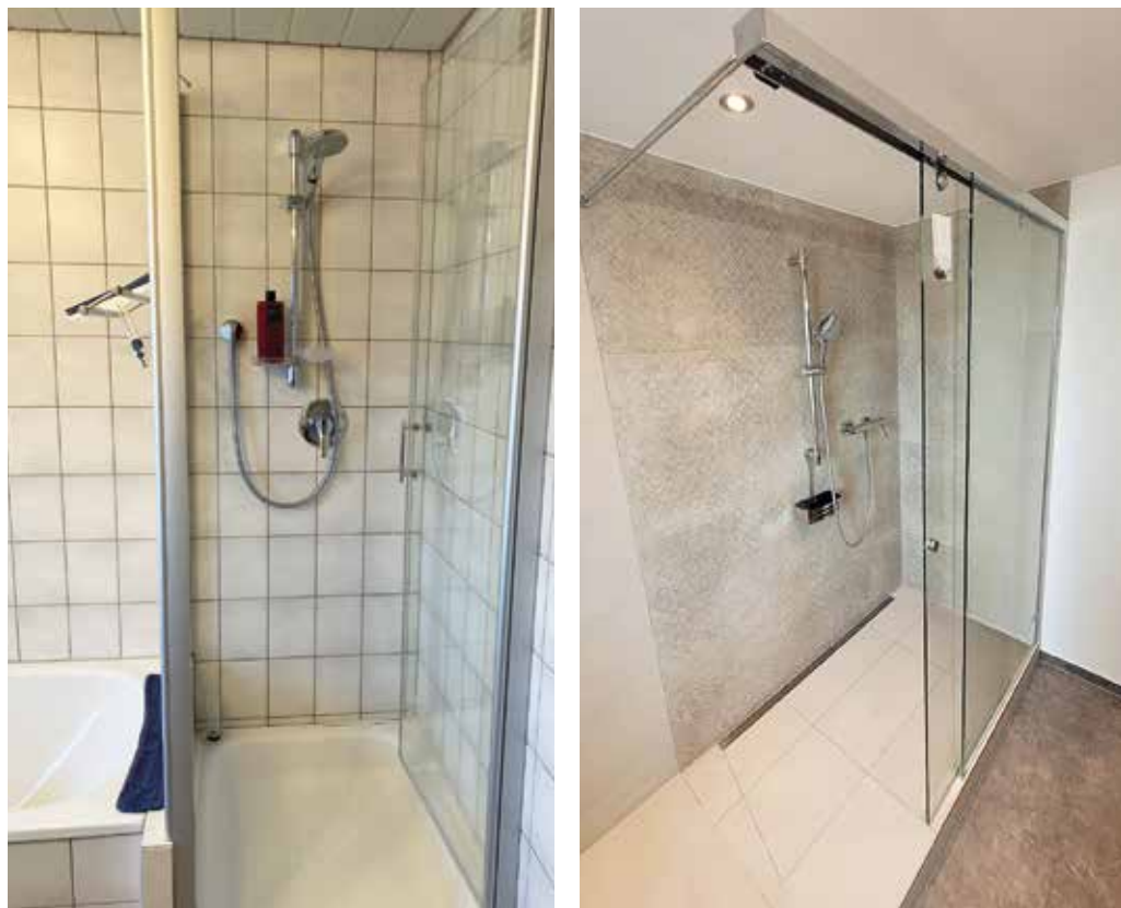
Bei der Teilmodernisierung wurden die alte Wanne und Dusche durch eine barrierearme Dusche ersetzt, außerdem wurde neu gefliest. So entstand ein ganz neues Ambiente. Fotos: Fa. Häfele
