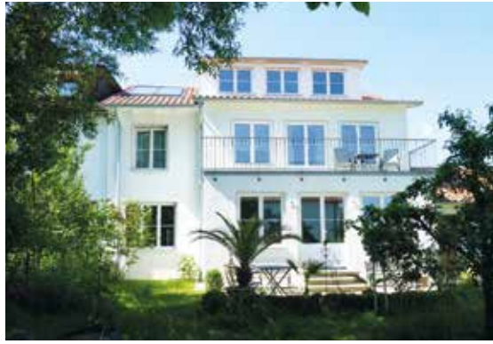
Sanierung_Friedrichshafen: Stuckateure können auch Flächenheizungen in Decken oder Wände einbauen, wenn das Gesamtkonzept stimmt. Foto: Zunkunft Altbau Wolff
